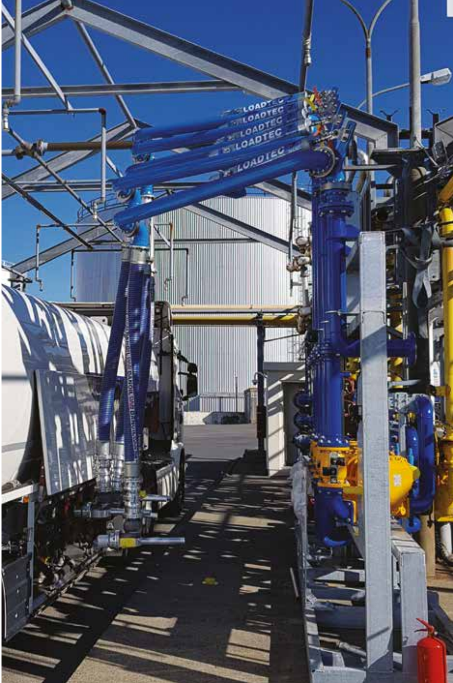
Brazos de carga de manguera inferior múltiple con cruce para carga de combustibles - Islandia - Fuels Industry
